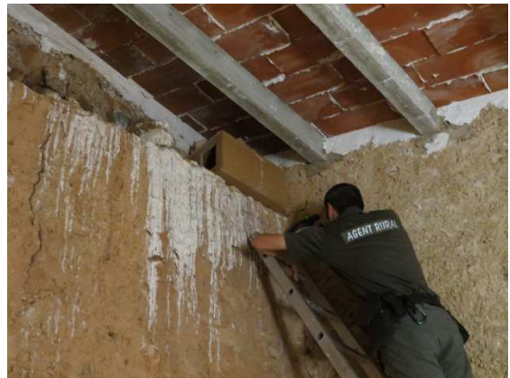
29.09.2015 Fer forats amb el trepant per posar fusta davantera de camuflatge per evitar el vandalisme.
