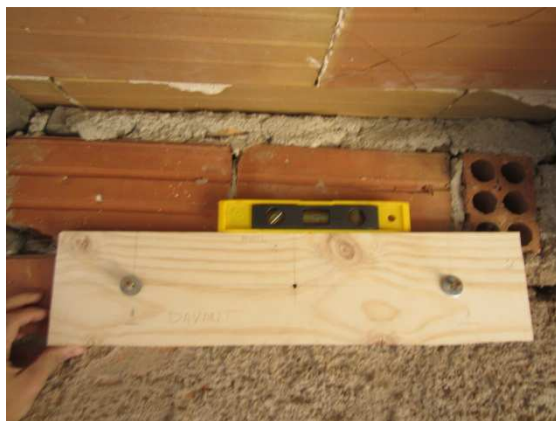
Col·locant el nivell
