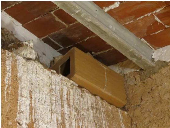
22.10.2015 Col·locació de la caixa.
