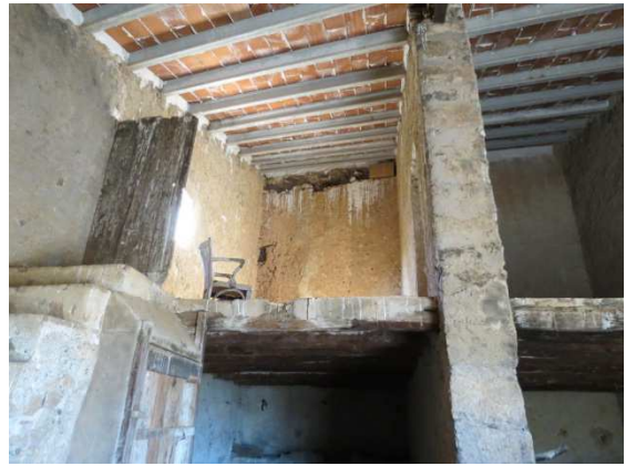
22.10.2015 Col·locació de la caixa.
